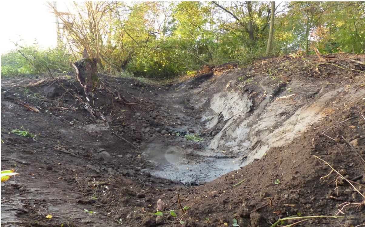
Obwohl hier tief ausgekoffert wurde, gelang ( noch) keine Verbindung zum Grundwasser.Das hängt sicher mit dem lehmigen Boden zusammen, der die Senke nach unten abdichtet – eine Chance, dass sich hier Regenwasser für längere Zeit hält.
