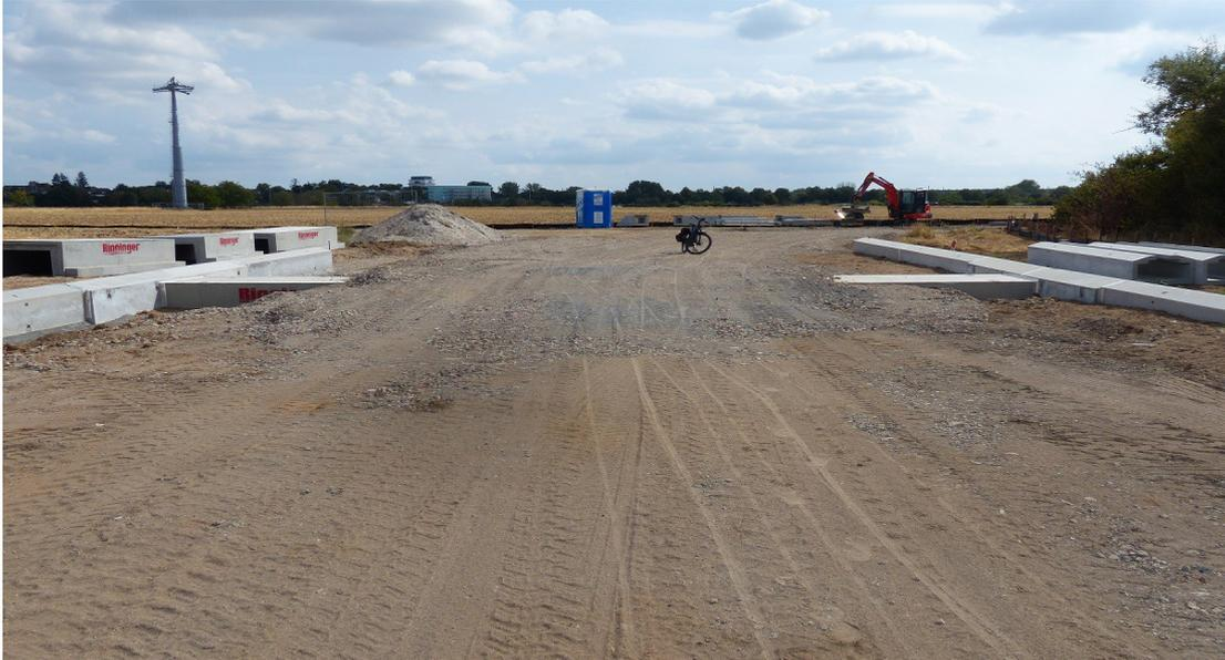
*Wenn die Asphaltdecke auf dem Radweg aufgebracht ist, wird von den Tunnelementen nichts mehr zu sehen sein.*
