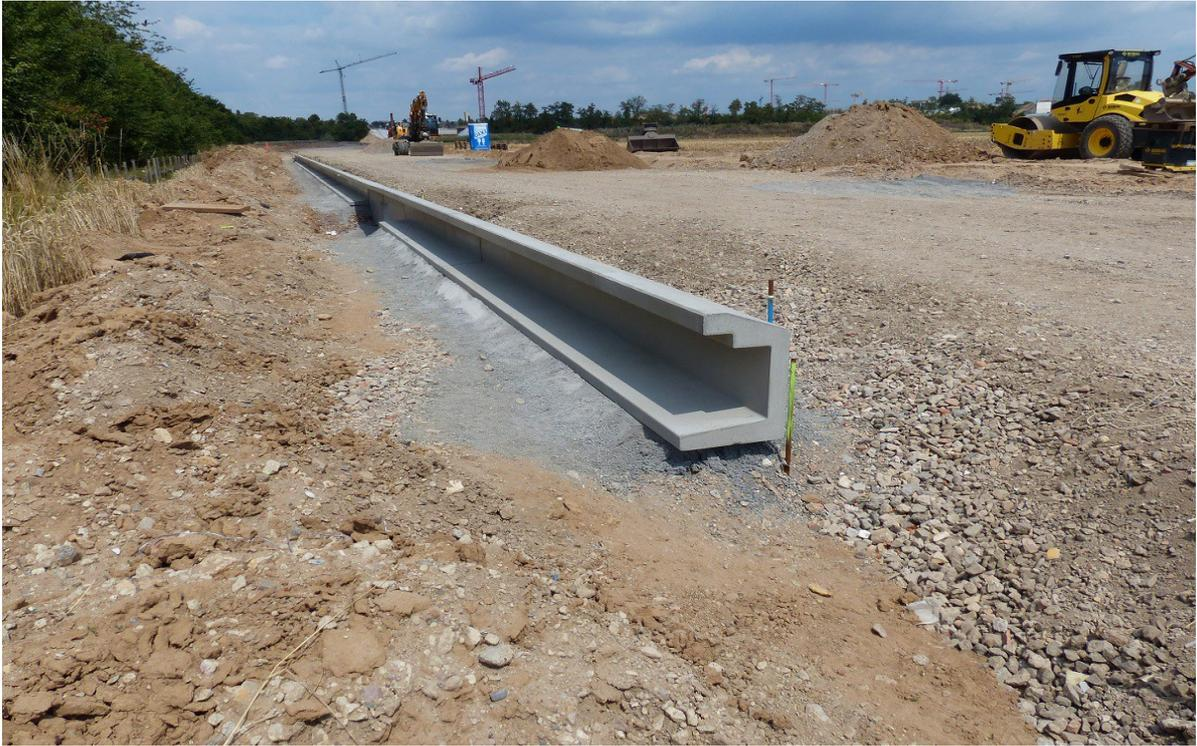
Gut erkennbar das Profil des Leitsystems. So wird ein Übersteigen verhindert
