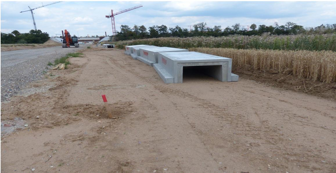
Auf dem ersten Foto in der Mitte des Leitsystems die Aussparung, an die die Tunnelsysteme andocken werden. Das zweite Foto zeigt einige der Tunnelelemente.
