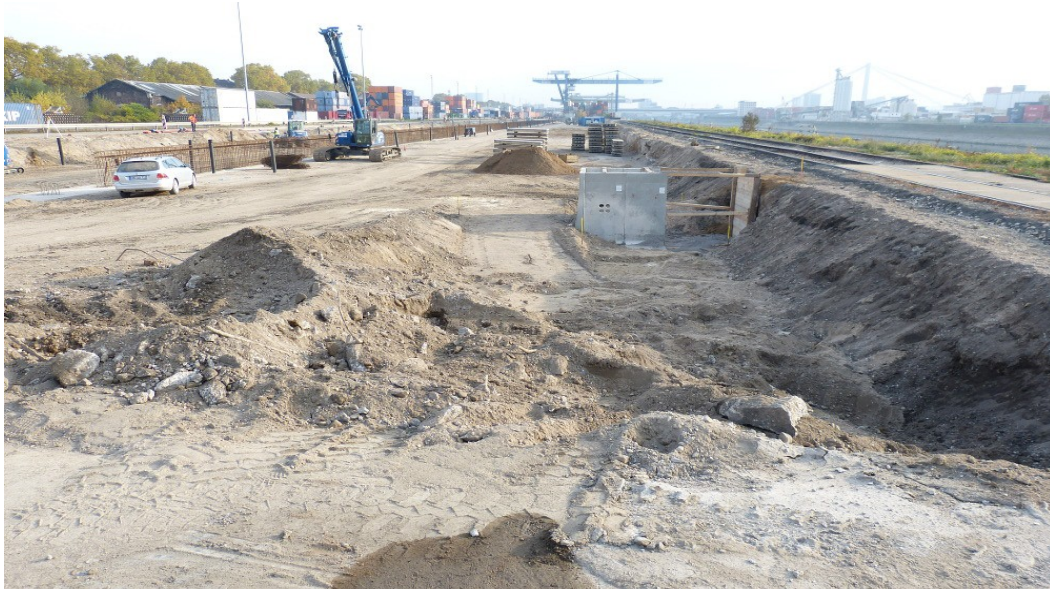
Das Bild zeigt die Arbeiten auf der Baustelle.
