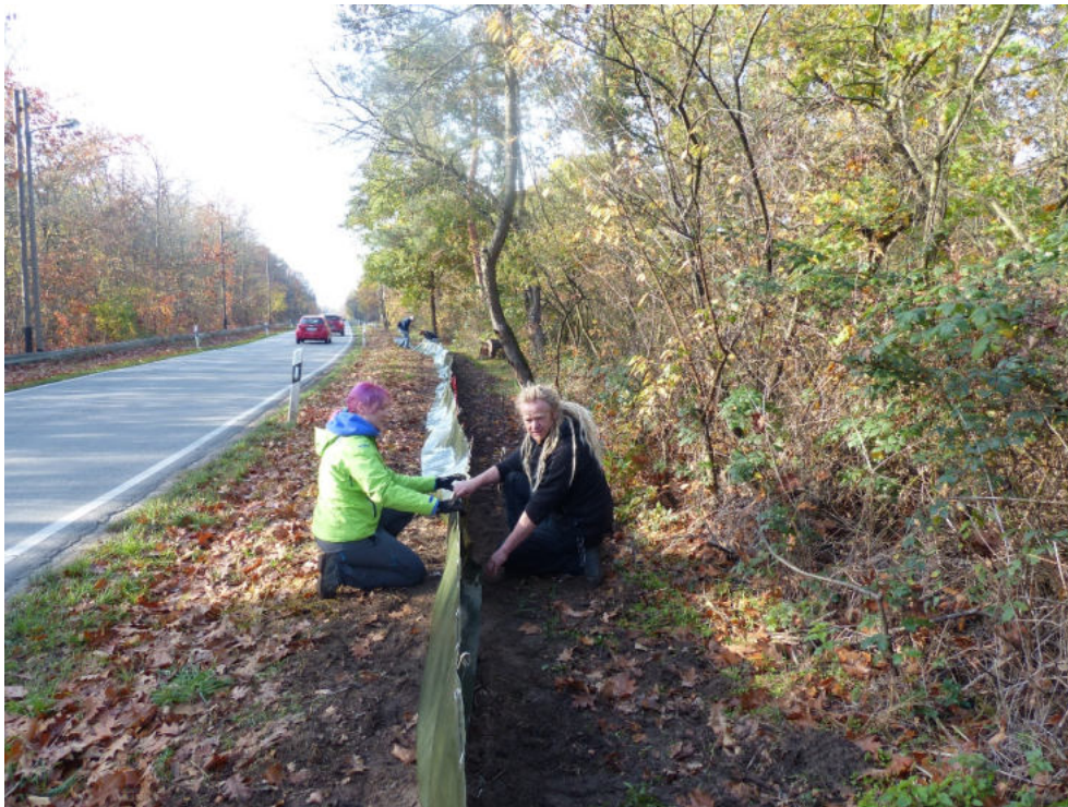
Michaela B. und Michael R. beim Einbau des neuen Fangzauns
