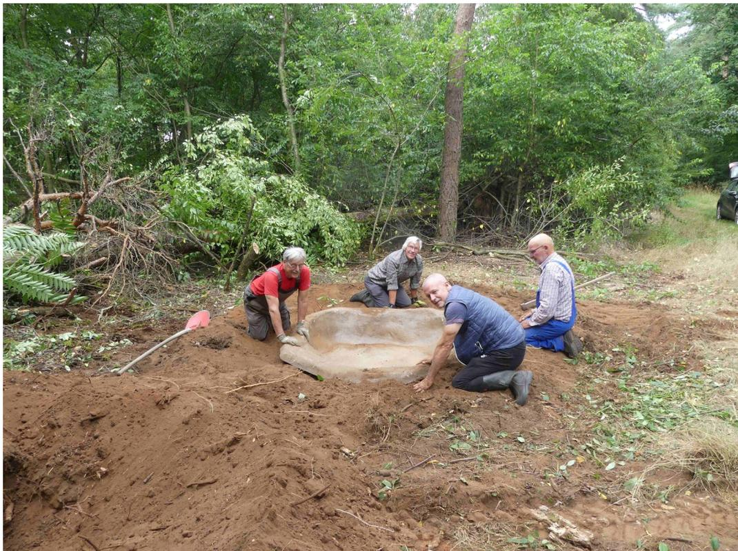
Hohlräume unter dem Becken werden mit Erde/Sand aufgefüllt
