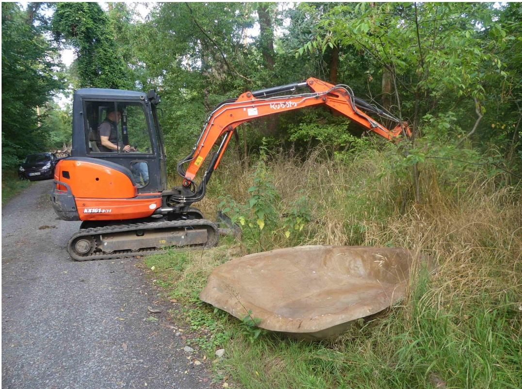
Nach dem Ausbaggern wird das Becken in die Senke gelegt und Erde beigefüllt
