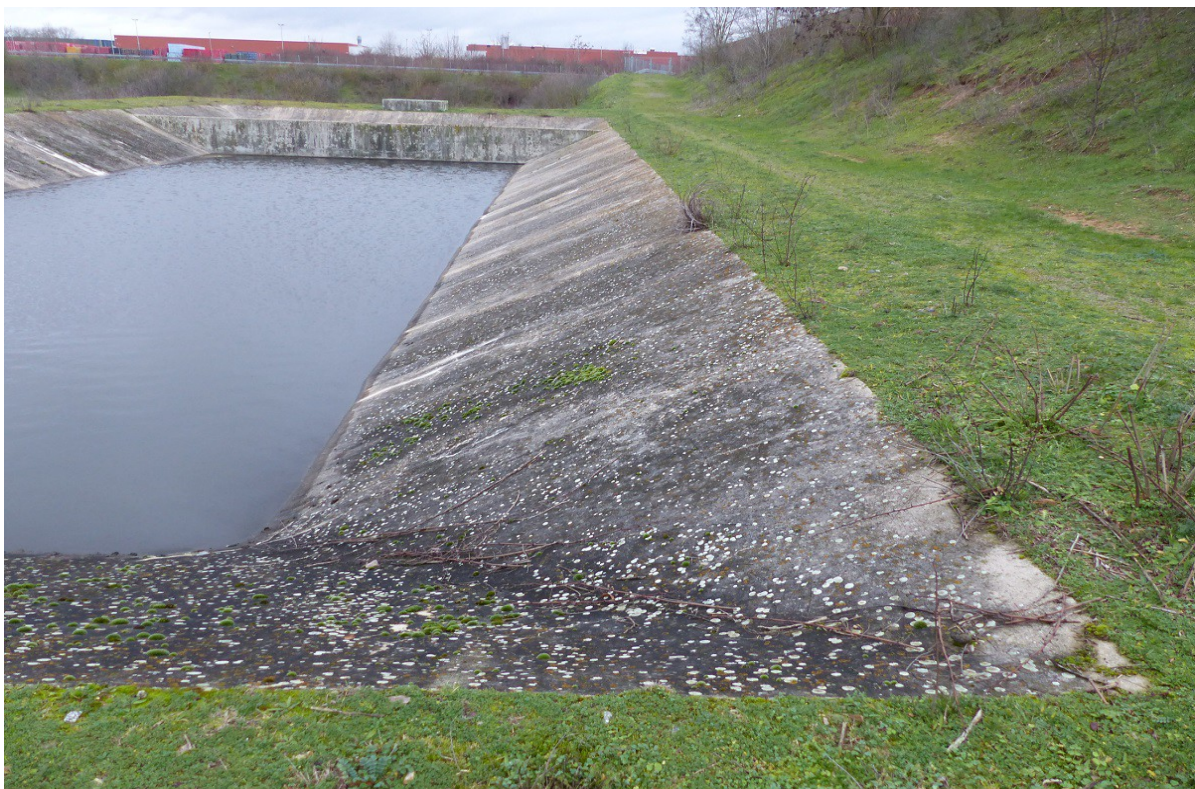
Eines der insgesamt 3 Becken
