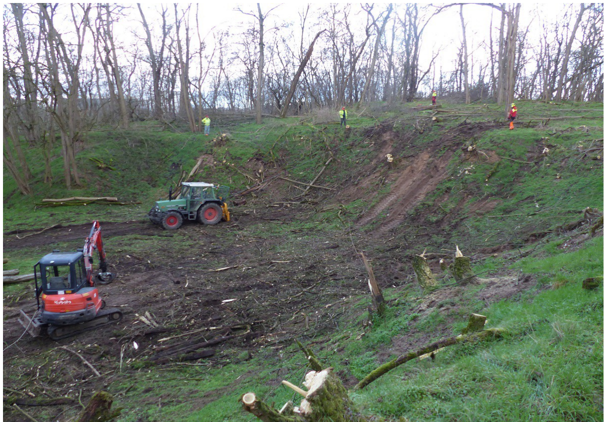
Beginn der Rodungsarbeiten auf der Dünenkuppe.
